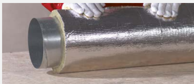
Krok 2 – owinięcie kanału izolacją.
