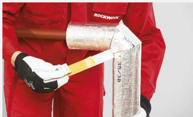
Sklejenie połączeń poprzecznych taśmą aluminiową.
