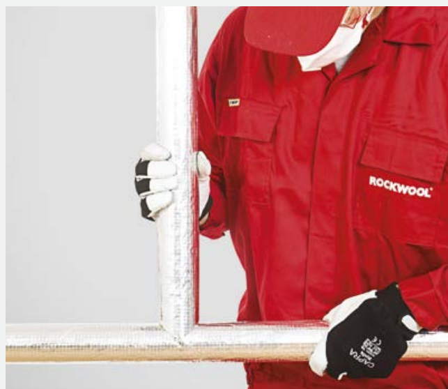
Dopasowanie łączonych odcinków.
