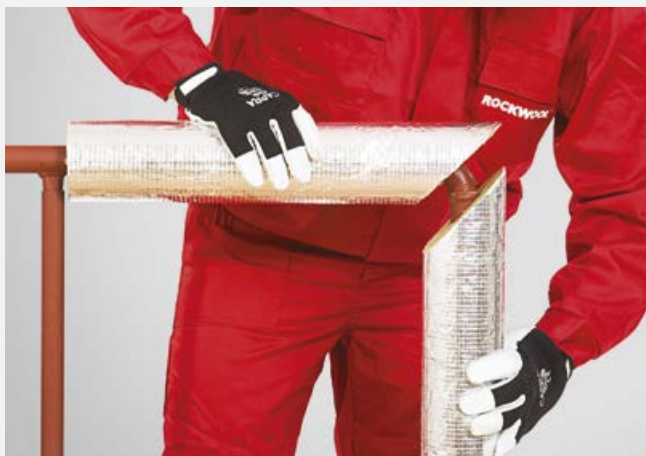
Dopasowanie obu elementów izolacji kolana.
