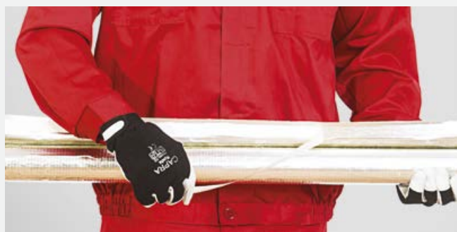
Ściąganie taśmy PE z zakładki samoprzylepnej.
