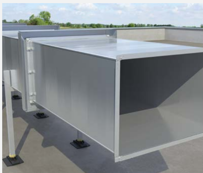
Mocowanie zetowników do powierzchni kanału.
