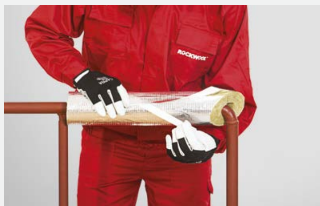
Sklejenie połączenia wzdłużnego zakładką samoprzylepną.
