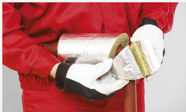
Montaż jednego segmentu kolanowego.
