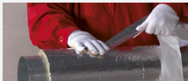
Krok 3 – uszczelnienie taśmą aluminiową połączeń podłużnych i poprzecznych.
